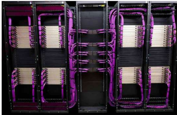
[그림 41] AWS 데이터센터 랙에 사용되는 크레도 테크놀로지의 AEC 케이블
